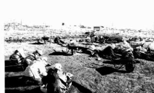
掘削作業風景
