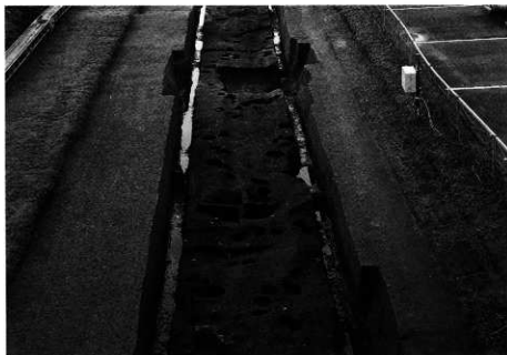
1. S K-123-126-134 完備状況 (東から)
