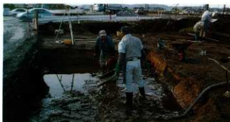
'02年10月 H93調査風景 常時排水しても水溜りのまま
