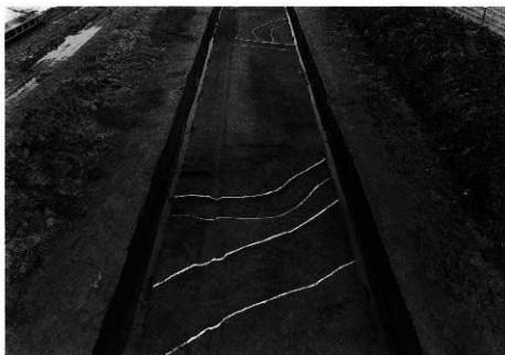
1. S D-103-104-105-106 完掘状況(南から)
