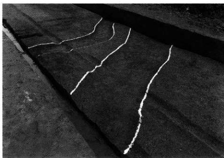
3. S D-104-105 完掘状況(南西から)
