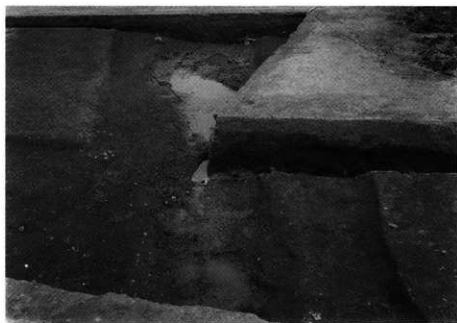
3. S D-1109 完掘状況 (西から)
