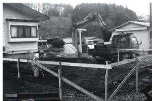
東裏遺跡 工事立会
