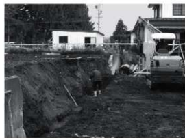
海端遺跡 工事立会
