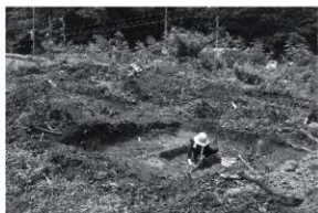
1. 国道18号野尻バイパス道路改良予定地 Ⅵ区の調査風景2
