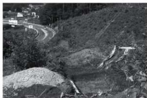
4. 国道18号野尻バイパス道路改良予定地 Ⅵ区6TP36完掘状況
