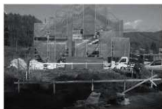
吹野原A遺跡 工事立会
