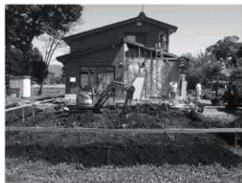
御料遺跡 工事立会
