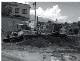
向原遺跡 工事立会
