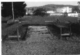
小古間遺跡 工事立会
