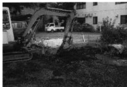
立が鼻遺跡 工事立会
