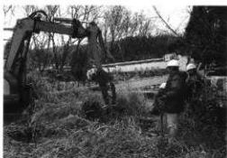
高山遺跡 工事立会
