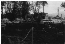
小丸山公園遺跡 工事立会
