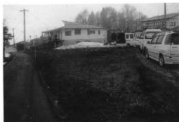
緑ヶ丘道路 工事立会
