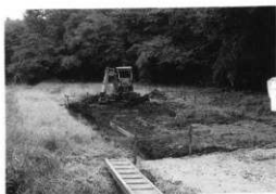
向原遺跡 工事立会
