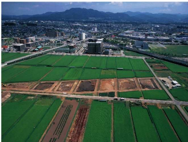
5区全景（西より）
