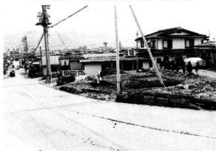
中道遺跡調査区全景 (西から)
