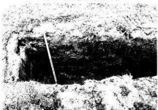
トレンチ西壁 (東から)
