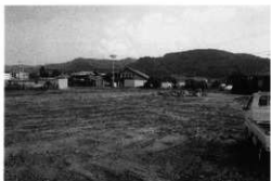
調査地区埋め戻し完了状況
