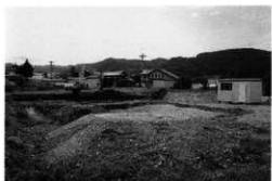
調査地区埋め戻し状況
