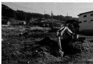
(3) 表土剥ぎ取り作業風景 (西から)
