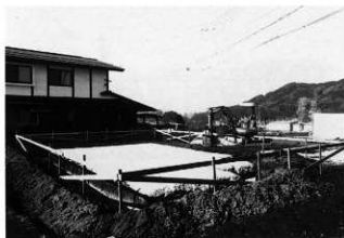
23-12 クネ内遺跡 (1) 調査区全景 (基礎掘削終了後) (南東から)
