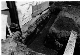
(3) 基礎北辺西側 (南西から)
