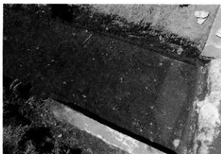
(2) 基礎北側 (南東から)
