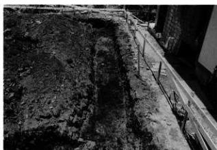
(3) 基礎東辺 (南から)
