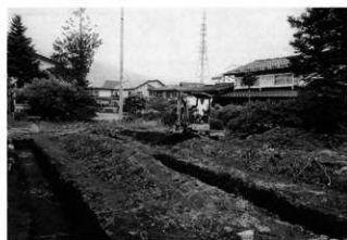
(6) 表土埋め戻し作業風景 (東から)
