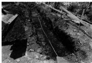
(2) 基礎北辺 (東から)
