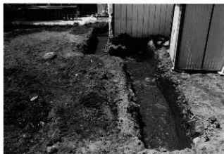
(2) 基礎北辺東側 (北東から)
