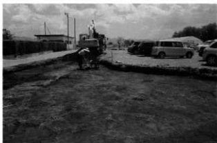
重機で表土を除去する—平成 22 年度— (西から)
