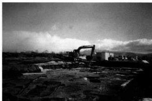
埋め戻し作業
