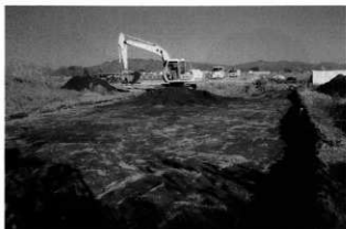
重機で表土を除去する—平成 21 年度— (西から)
