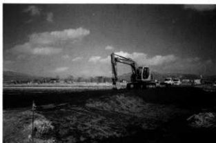
埋め戻し状況
