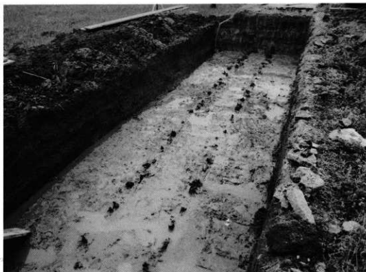
a. トレンチ南半暗渠検出状況
