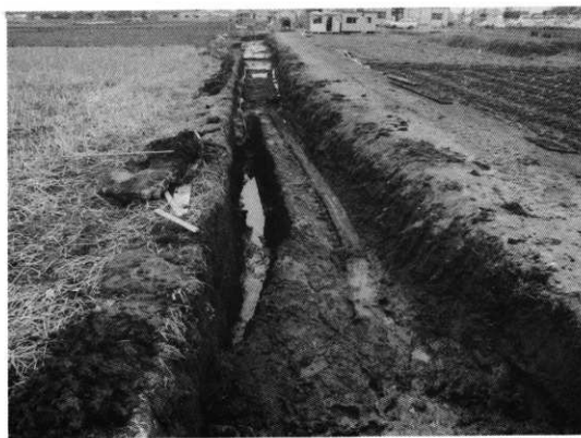
b. トレンチ全景（南から）
