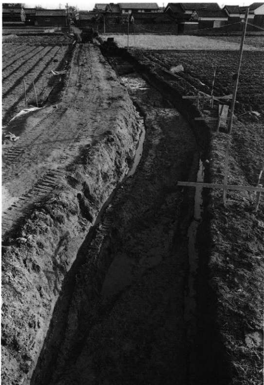
トレンチ中央部完掘状況
