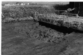
H13号住居址掘方（北西から）H11年度調査分
