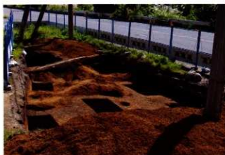
面的調査区内のテストピット配置 (北東より)
