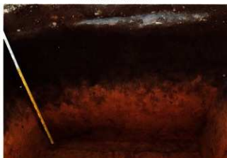
TP12 断面 (東より)
