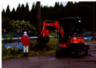
テストピットの表土掘削（南東より）
