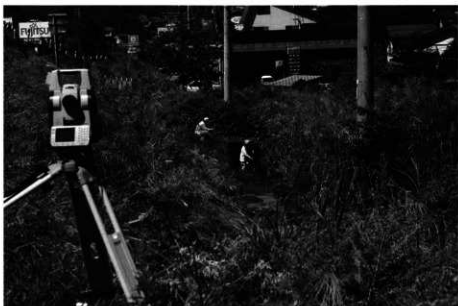
遺構測量支援システムによる測量風景
