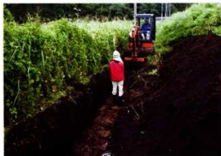
トレンチ表土掘削（北より）
