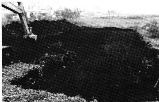
バックホーによる表土除去
