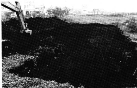
バックホーによる表土除去
