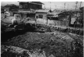
K区表土除去作業（東から）
