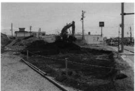
L区表土除去作業（西から）
