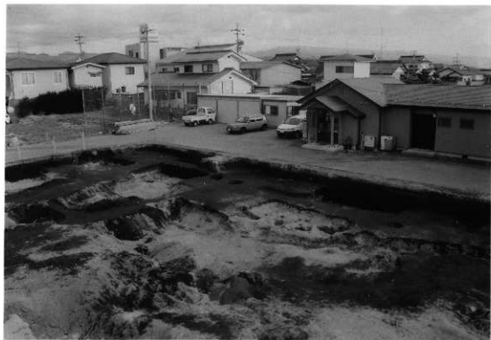
B区南側拡張部全景（北西から）
