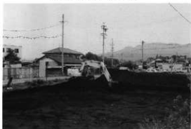
D区表土除去作業（西から）
