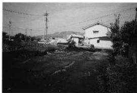
C区表土除去作業（西から）
