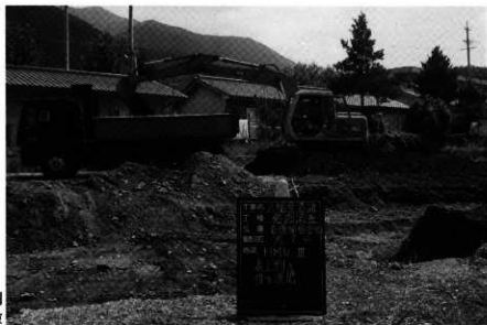
重機による表土剥 ～運搬
