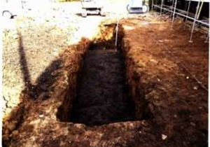
トレンチ完掘（南から）
