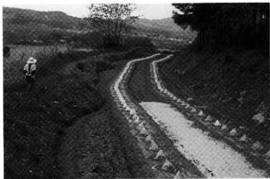
調査地点より 西方を望む
