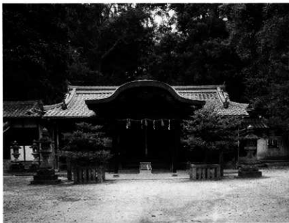
解体前拝殿（東から）
