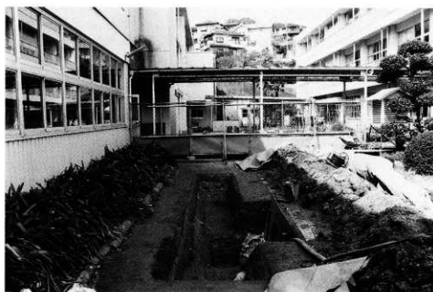
2 トレンチ掘削状況 (東から)
