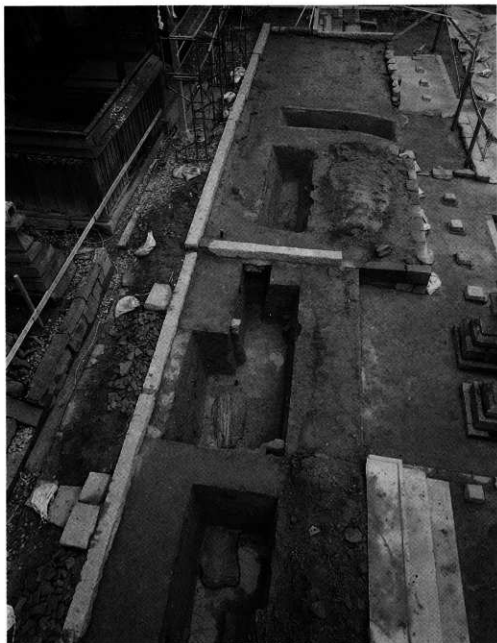
1・2トレンチ 石列検出状況 (南から)
