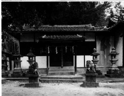
解体前南拝殿（東から）
