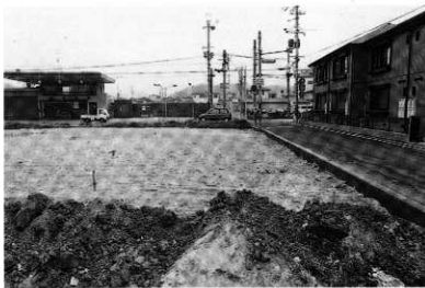
南トレンチ 調査前全景 (西から)
