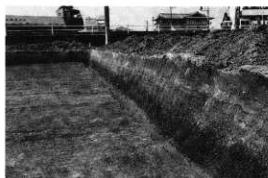
写真5 西調査区北壁土層断面（南東から）
