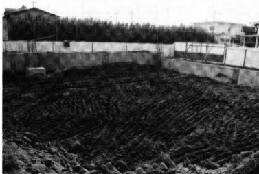
写真1 調査前の状況
