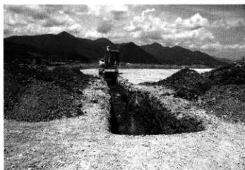
トレンチ掘削状況 (東より)
