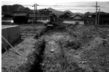
トレンチ掘削状況 (東より)
