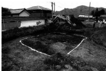
トレンチ検出状況 (南東より)
