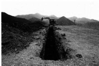
トレンチ検出状況 (東より)
