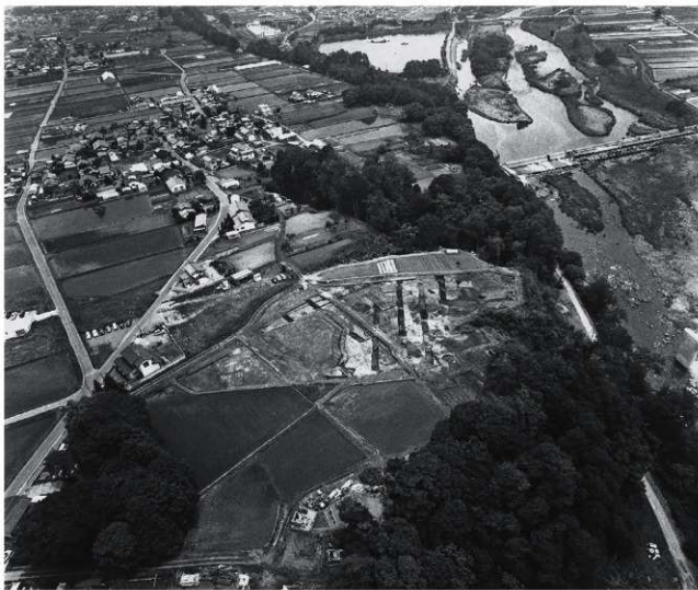
道路遠景 (西より)
