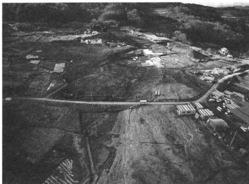
II・Ⅱ区調査風景
