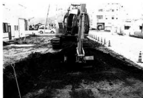
バックホーによる表土掘削(東1区)
