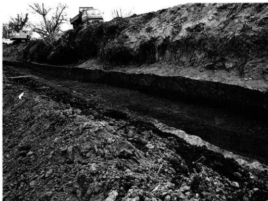
b. 唐古池堤防盛土堆積状況（第1トレンチ中央）
