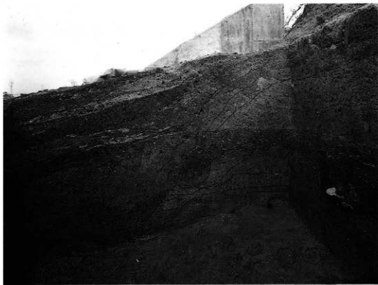
a. 唐古池堤防盛土堆積状況（第1トレンチ北端）
