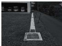
施工後の現地（南から）
