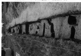
写真70 B区全景 (南東から)
