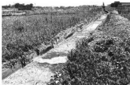
写真6 湖東線(大馬久保)(北西方より)
