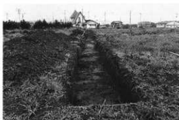
写真7 6-20号線(西曾根)(西方より)
