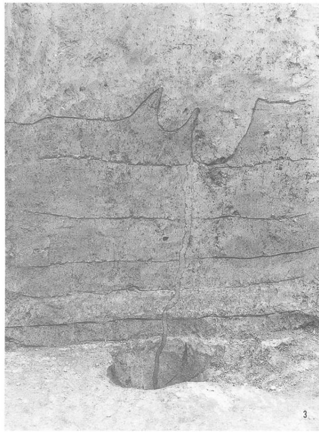
2 噴砂跡 (2-2区東側 側道部分)
