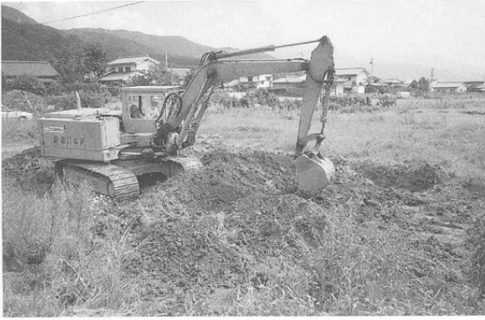
重機による試掘
