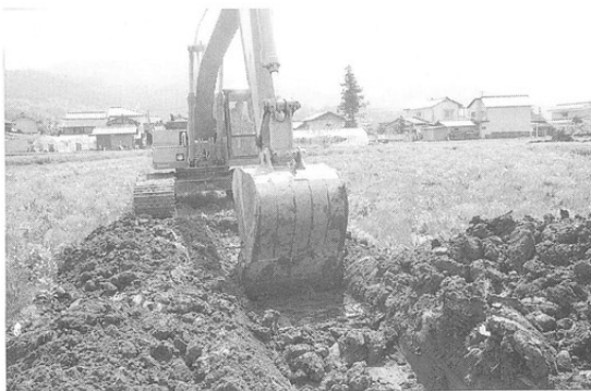
重機による試掘トレンチ
