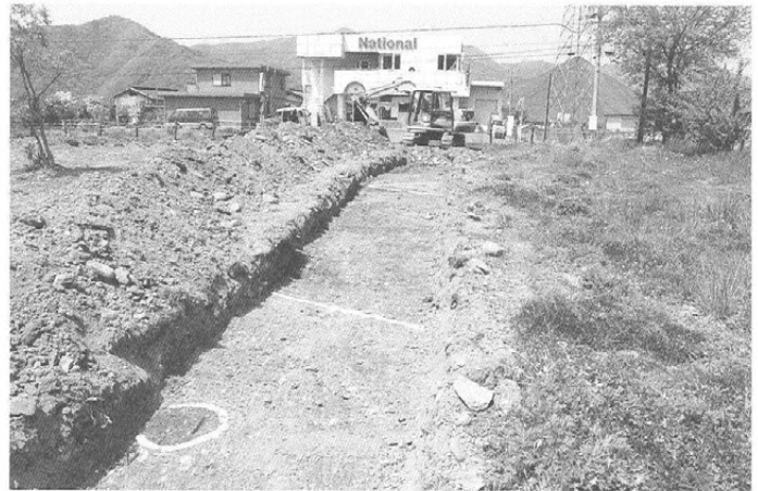
トレンチ掘削状況 (東より)
