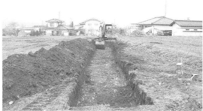
トレンチ掘削状況（東より）
