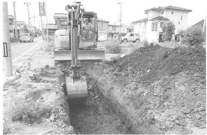
トレンチ検出状況 (東より)
