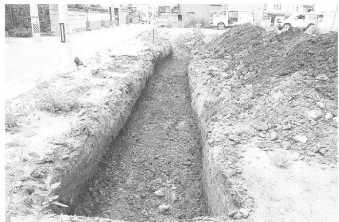
トレンチ検出状況 (北より)
