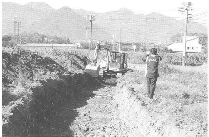
トレンチ掘削状況（東より）
