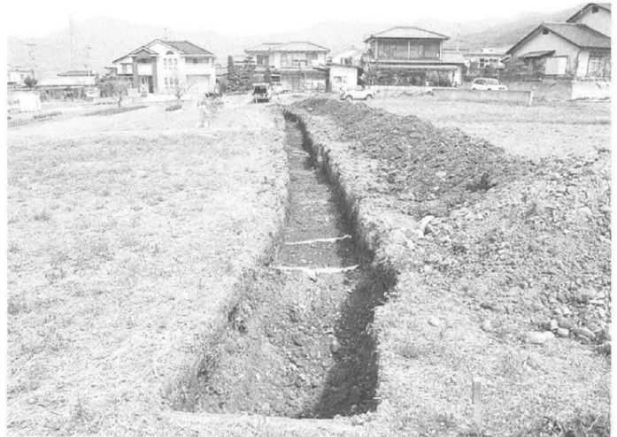
1号トレンチ検出状況 (南より)
