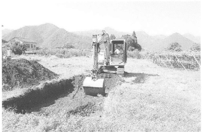
トレンチ掘削状況 (東より)
