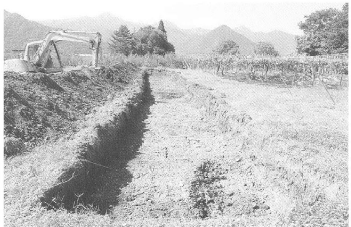
トレンチ検出状況 (東より)
