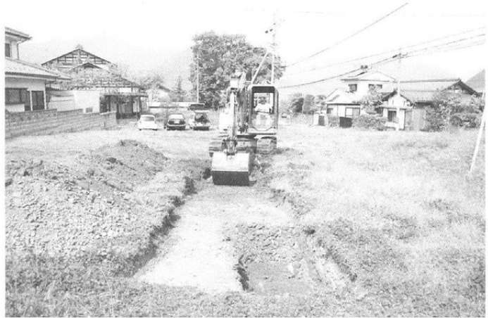
トレンチ掘削状況 (東より)
