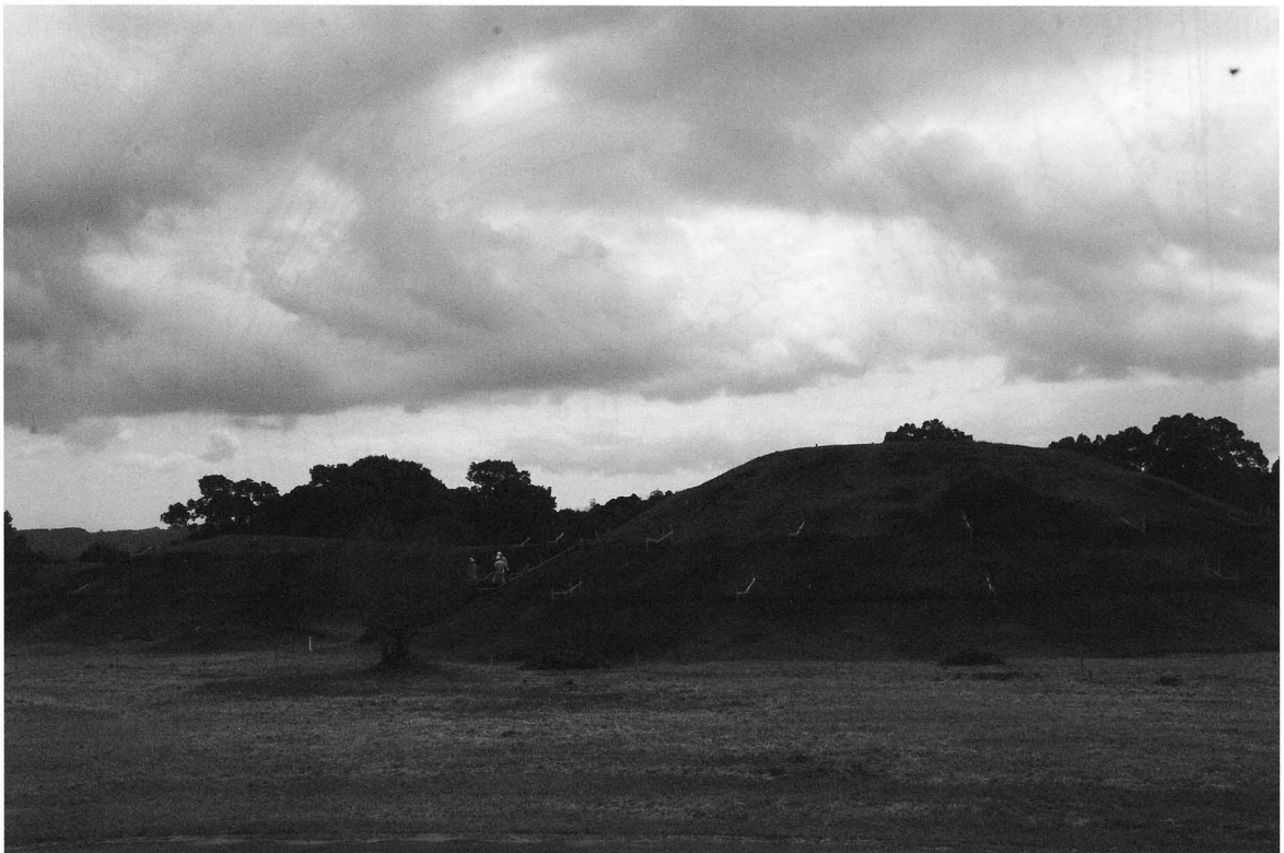
整備工事状況
