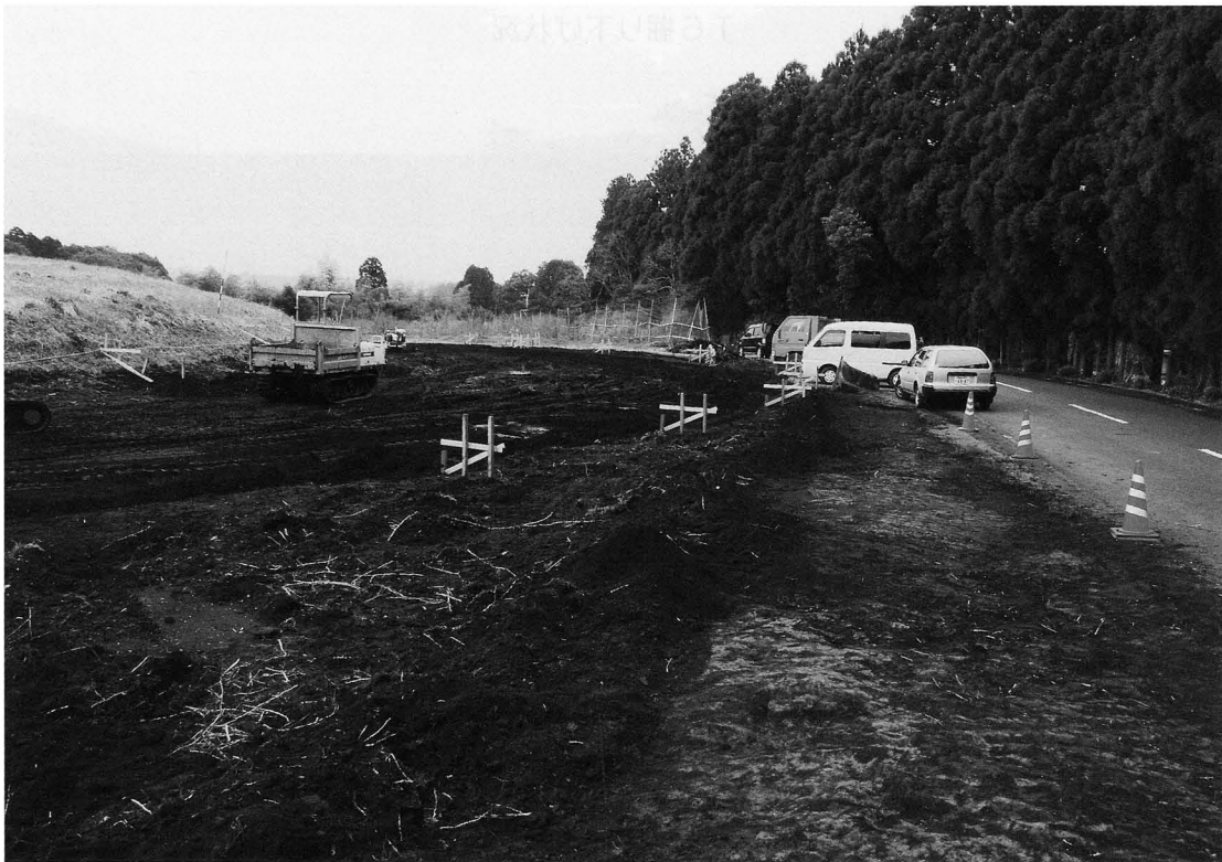
整備工事状況
