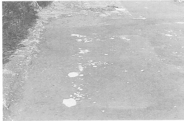
同 西半部 (南より)
