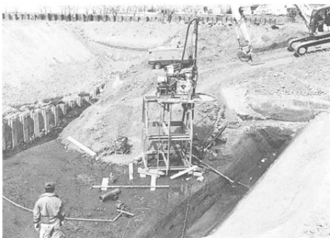
図4 排水用井戸の掘削
