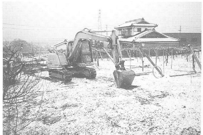
1号トレンチ掘削状況 南東より
