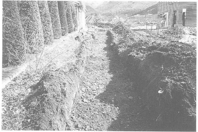
2号トレンチ検出状況 西より
