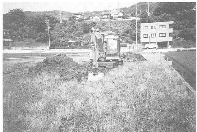
4号トレンチ検出状況 西より
