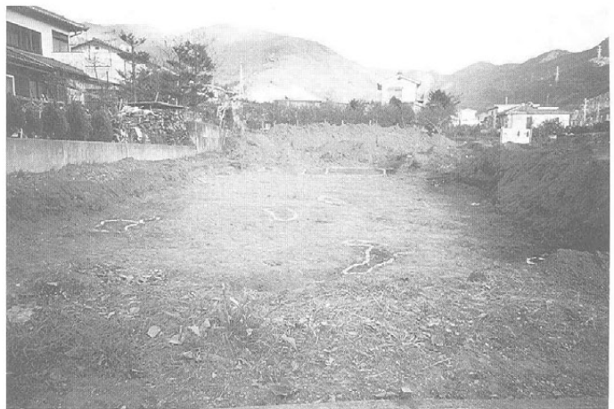
1号トレンチ検出状況 西より
