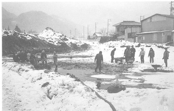
除雪・排水作業
