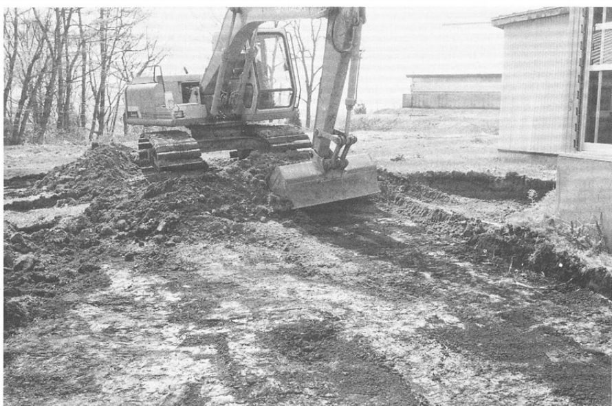
重機による表土除去
