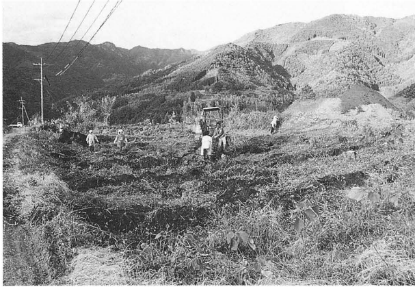
伐開作業状況
