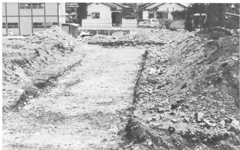
校舎基礎 掘削
