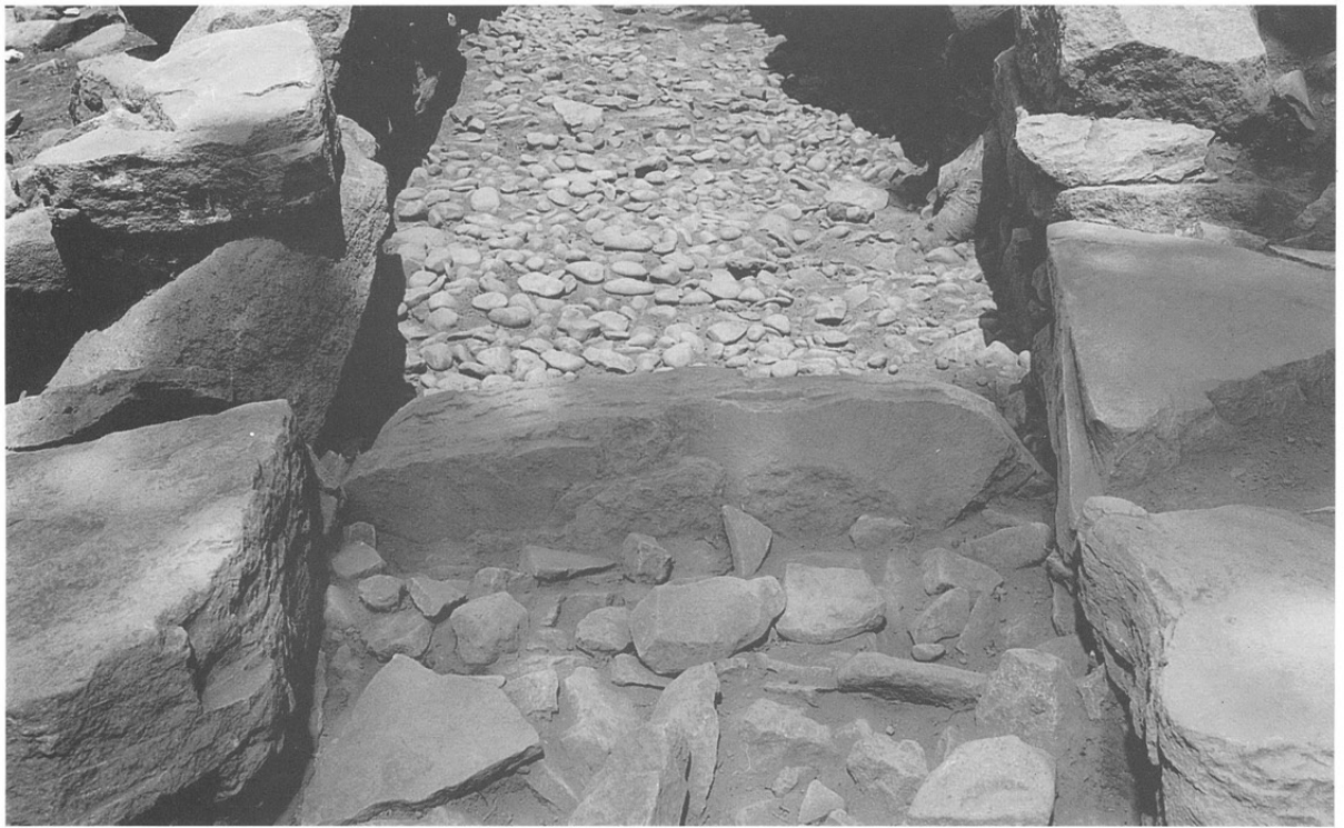
第25号墳框石開口方向より
