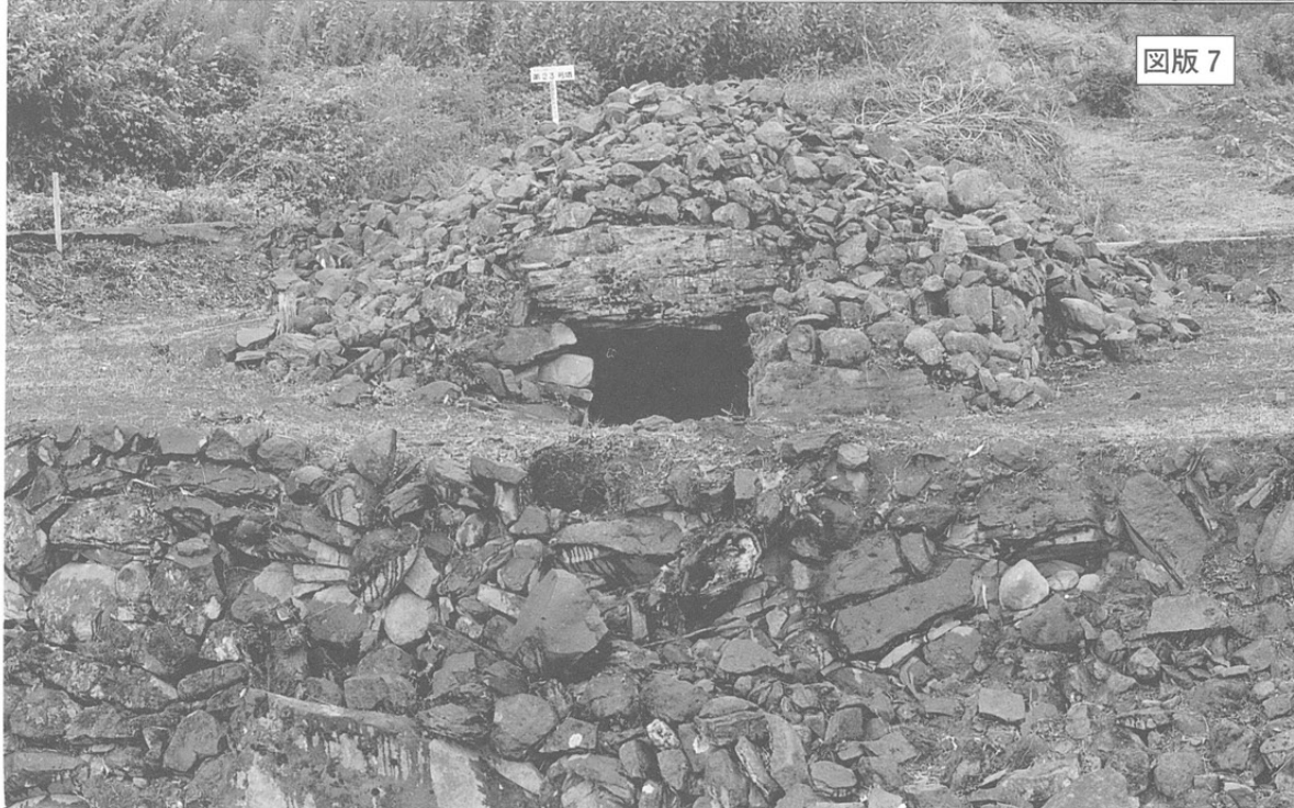
第23号墳調査前石室 開口方向より
