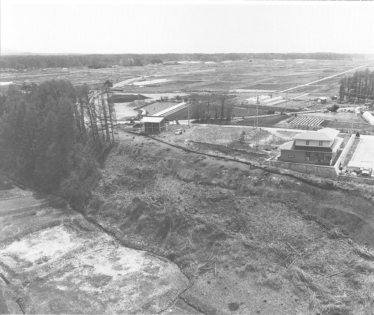
平成13年度 調査区全景
