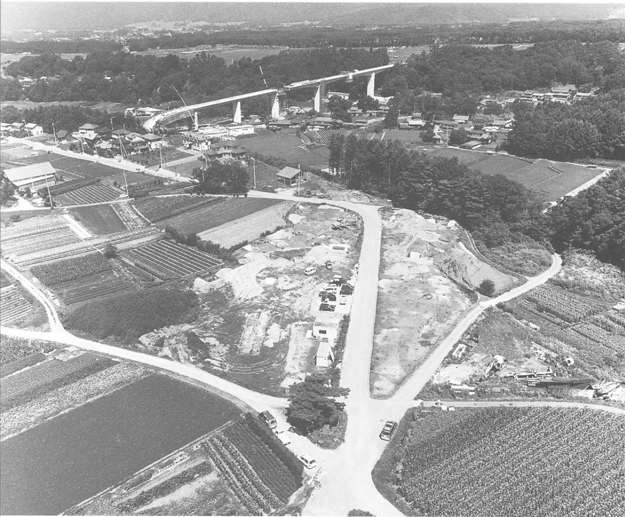
平成12年度 調査区全景
