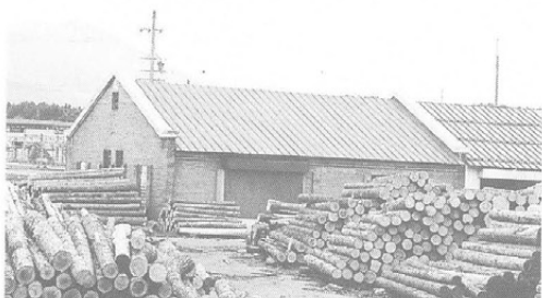
写真6→ 東洋化学 工業棟の 煉瓦棟
