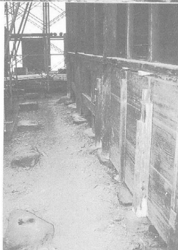
写真8→ 真田信重 靈屋の縁下
