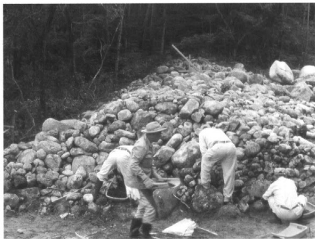
H11年度 乳川石堤 作業風景
