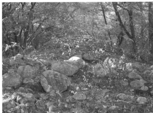
H11年度 乳川石堤 (石堤上部)
