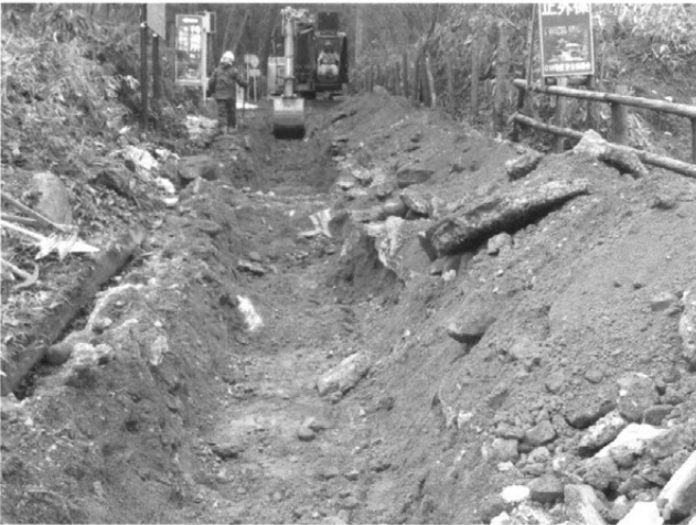
H15年度 神明原遺跡 試掘トレンチ掘削
